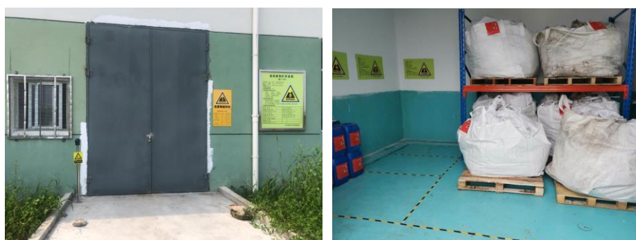
图 4.1-8 危险废物暂存间内外部
